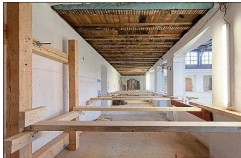
Stark sanierungsbedürftig waren die Dächer. Ein Großteil der Deckenbalkenköpfe war verrottet. Die Umgänge des Dommuseums wurden zusätzlich mit Balken ausgesteift. Das denkmalgeschützte Lichthofdach wurde kartiert.
