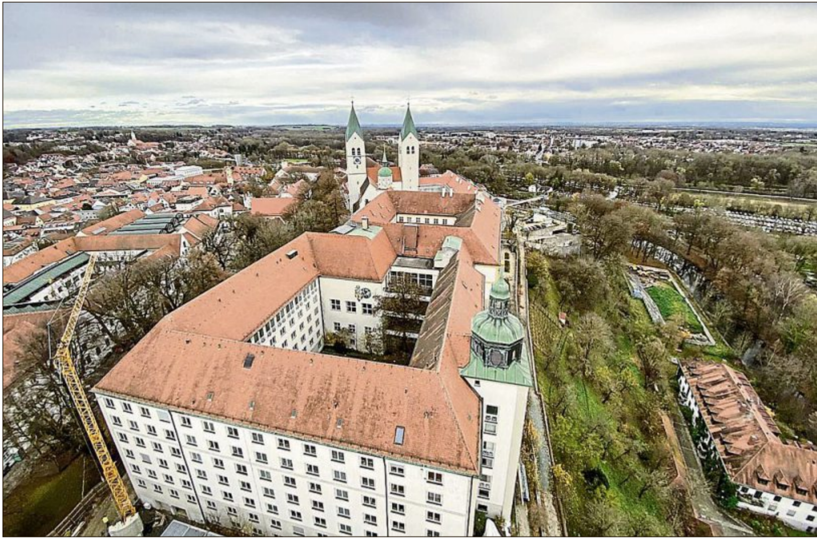
Die Sanierungsmaßnahmen auf dem Freisinger Domberg umfassen insgesamt 30 Einzelprojekte.
