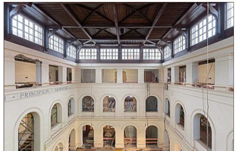
Stark sanierungsbedürftig waren die Dächer. Ein Großteil der Deckenbalkenköpfe war verrottet. Die Umgänge des Dommuseums wurden zusätzlich mit Balken ausgesteift. Das denkmalgeschützte Lichthofdach wurde kartiert.
